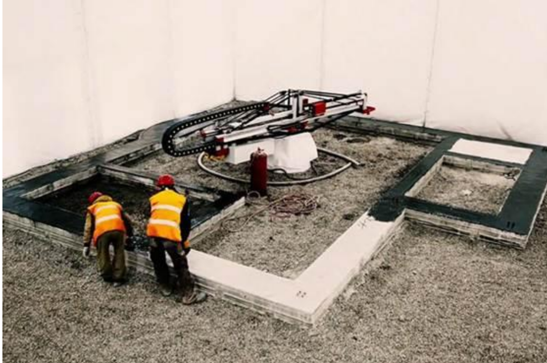
Abbildung: Ein mobiler Roboter-3D-Drucker beim Bau der Betonwände eines kleinen Hauses (Apis Cor-Projekt). Eine solche Automatisierung kann den Rohbau eines Gebäudes innerhalb weniger Stunden und mit minimalem Arbeitsaufwand errichten. Dies läutet eine Zukunft mit drastisch niedrigeren Baukosten ein.
